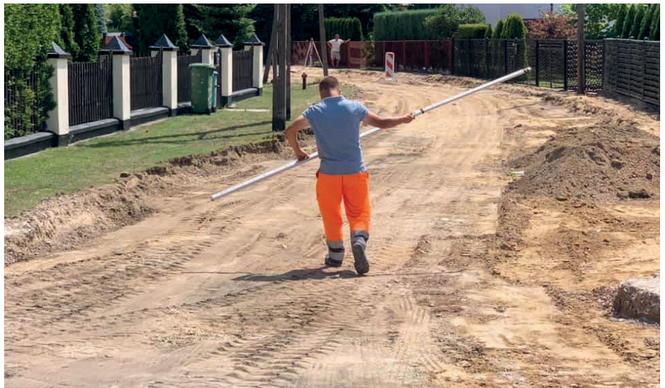
Na przełomie lipca i sierpnia ruszyły prace na ulicy Reja w Piekoszowie. (fot. UG)
