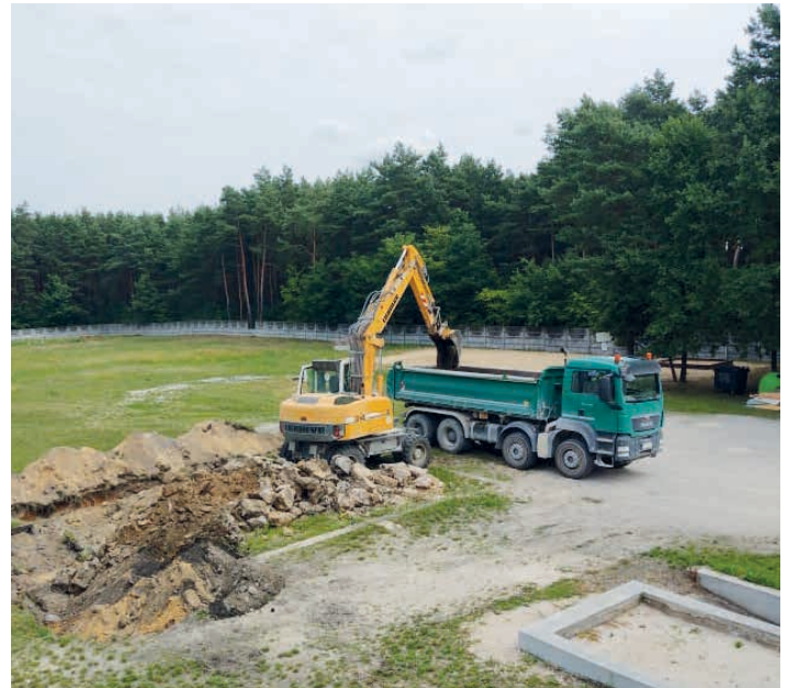
Podczas prac na placu zabaw. (fot. SP Łosień)
