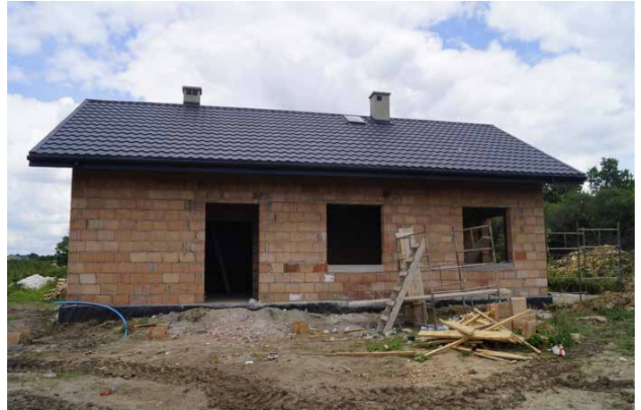
Budynek przy ujęciu wody w Lesicy. (fot. BCK)
