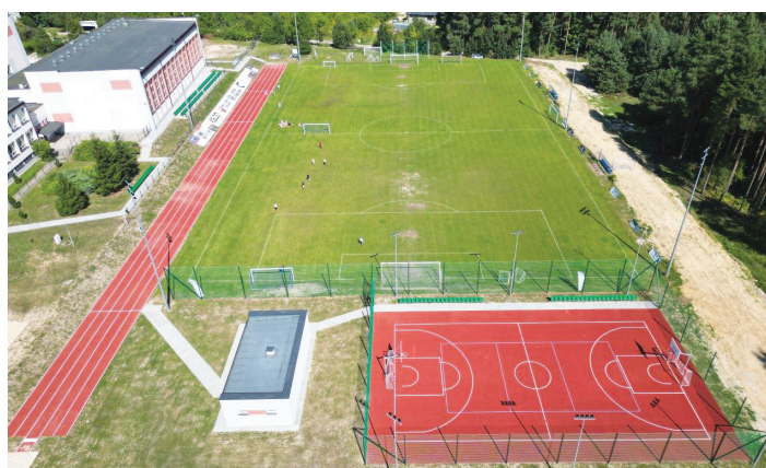
Nowoczesne boisko wielofunkcyjne wraz z oświetleniem przy ZPO w Piekoszowie.
