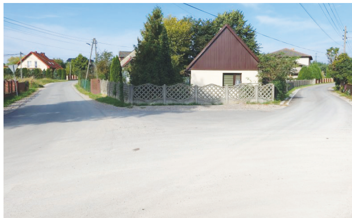
Nowa droga oraz sieć kanalizacyjna w Janowie.
