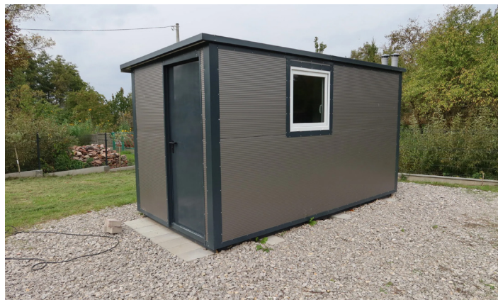
Zmodernizowana sieć wodociągowa w Gałęzicach.
