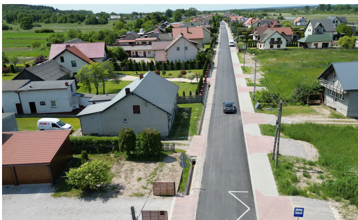
Kompleksowa przebudowa drogi w Łaziskach.
