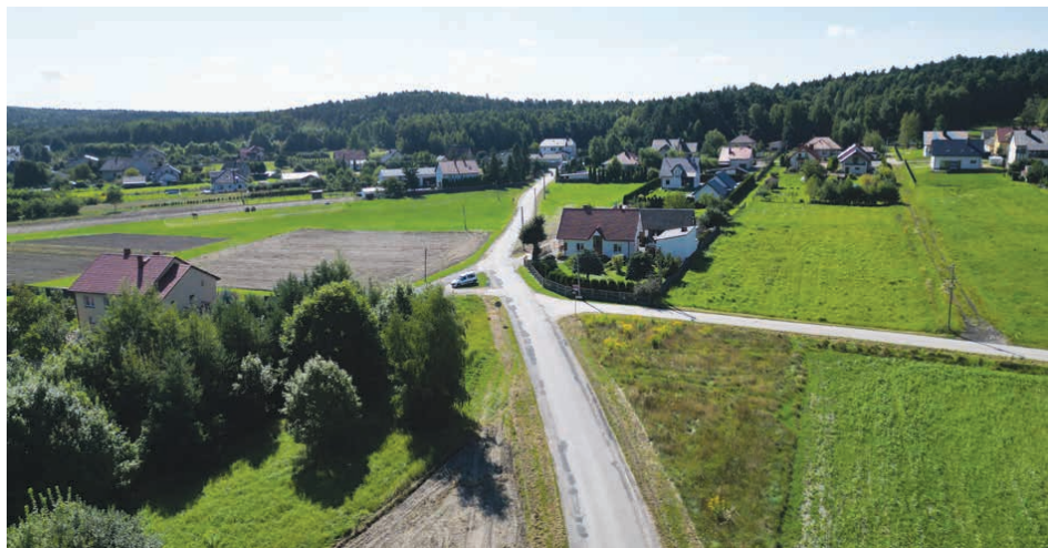
Droga na odcinku Jaworznia-Łaziska przejdzie kompleksowy remont. (fot. BCK)
