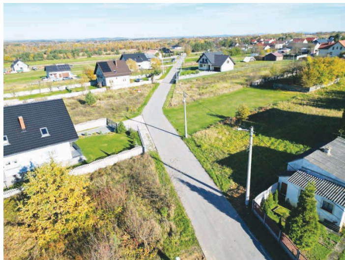
Ulica Kniaziowa w Rykoszynie przeszła kompleksową przebudowę na odcinku blisko 800 metrów. (fot. BCK)
