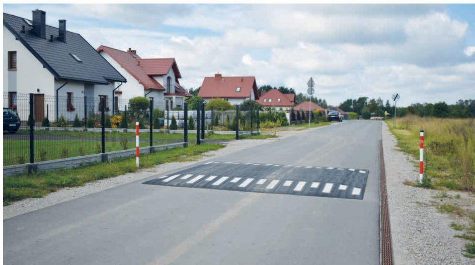
Przebudowane zostały także ulice Leśna i Południowa w Micigoździe. (fot. BCK)
